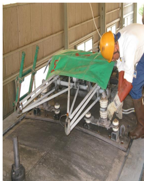
屋根上作業訓練（降雪対応）
