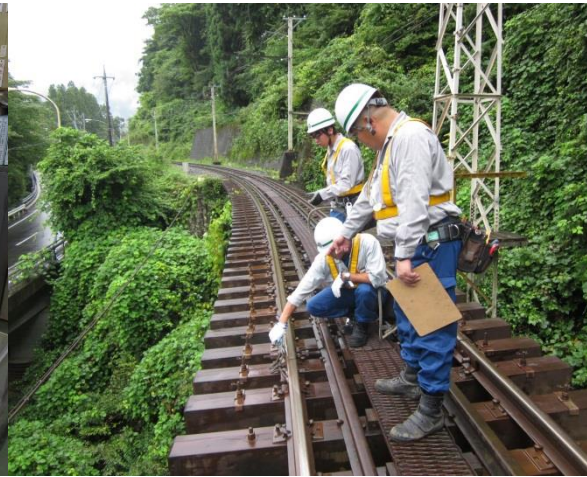
軌条を点検する施設班員（保線）
