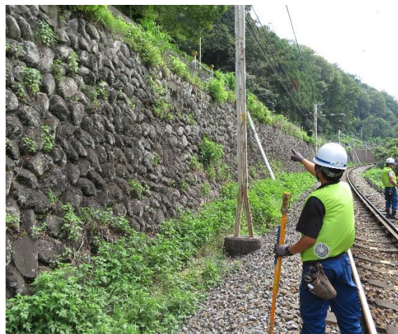
電気設備を点検する施設班員（電気班）
