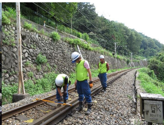
線路設備を点検する施設班員（保線班）
