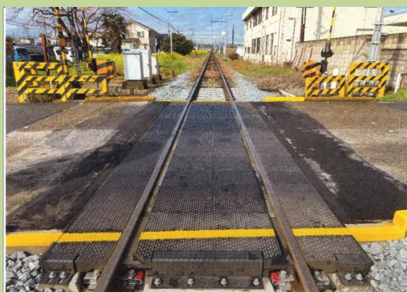
KG式弾性構造踏切に改善した石原No.9踏切道（左）と皆野No.3踏切道（右）
