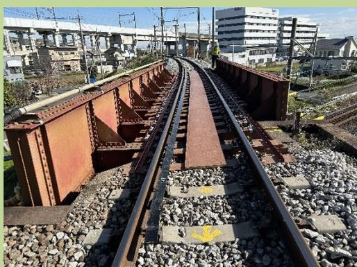
軌道の強化を目的としてPC化を推進し、軌間拡大や軌条のふく進、軌道変位を防止し、安全性を長期にわたって維持するため、経年劣化した並枕木、分岐枕木、橋枕木、継目枕木1301丁の交換を実施しました。
