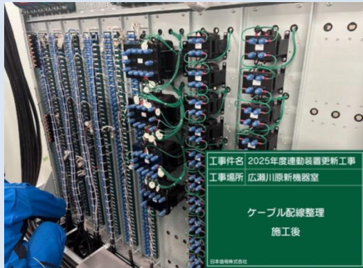
①広瀬川原駅連動装置更新（第二期）
