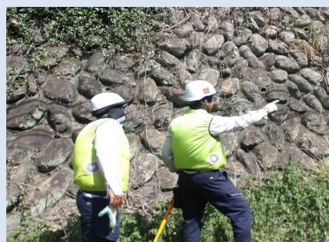
施設・設備点検
