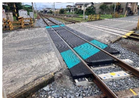
皆野 No.1 踏切道 KG 化工事
