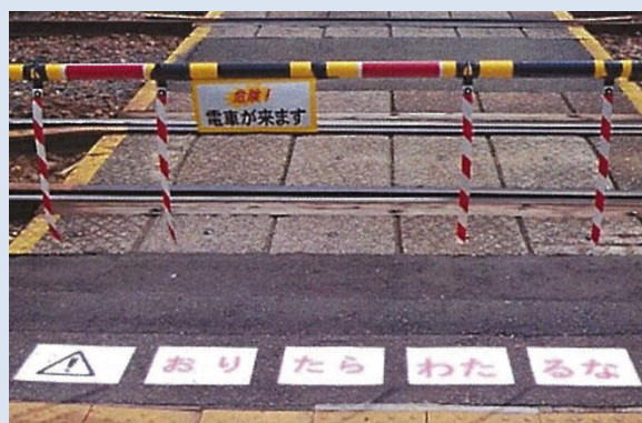
安全対策後の駅構内通路保安
