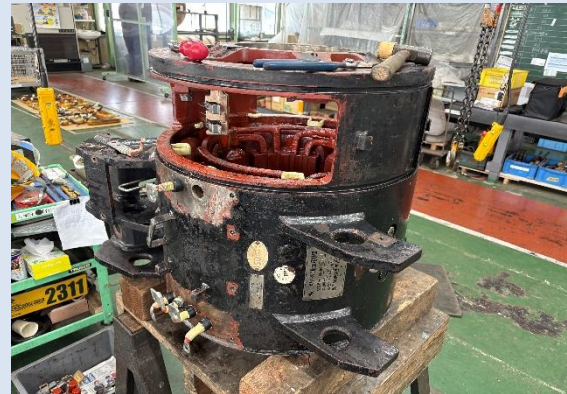
②主電動機絶縁更新工事
