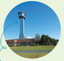
タワーのてっぺんは 古代蓮会館の展望室！
