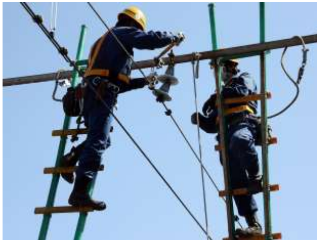
電気高所作業訓練
