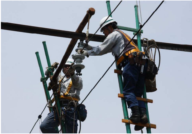
電気高所作業訓練
