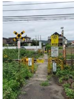
御花畑No.14 踏切道(秩父市)
