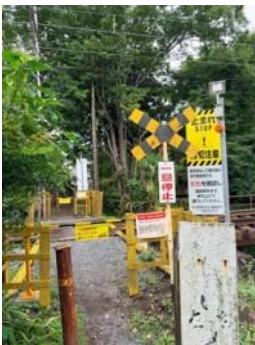
御花畑No.10 踏切道(秩父市)
